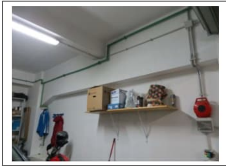
Fig. 26. Primo piano seminterrato. Box auto pignorato identificato al sub. 48. Interno
