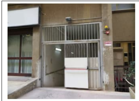
Fig. 12. Ingresso alla rampa del primo piano scantinato dal civico n. 38 di via Villa Heloise
