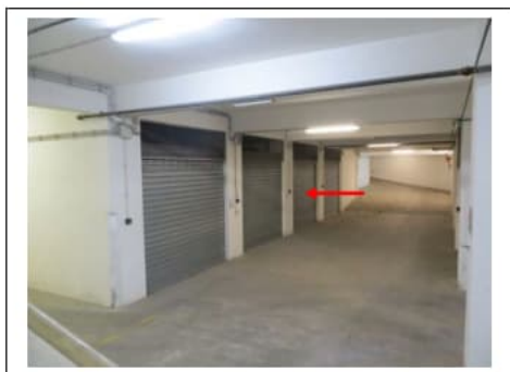
Fig. 24. Primo piano seminterrato. Box auto pignorato identificato al sub 29 (indicato con la freccia), visto dalla rampa di accesso dal civ. 38
