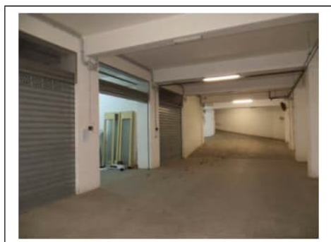
Fig. 26. Primo piano seminterrato. Box auto pignorato identificato al sub. 29 visto dalla rampa di accesso dal civ. 22
