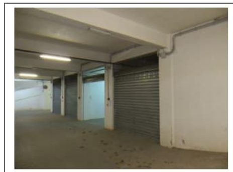
Fig. 25. Primo piano seminterrato. Box auto pignorato identificato al sub. 29 visto dalla rampa di accesso dal civ. 22
