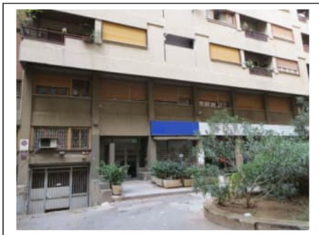
Fig. 6. La via Villa Heloise. Prospetto dell'edificio B dove sono ubicati gli accessi delle rampe del primo e secondo piano scantinato
