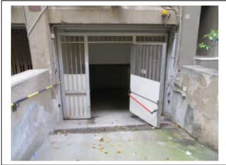
Fig. 10. Ingresso alla rampa del primo piano scantinato dal civico n. 22 di via Villa Heloise
