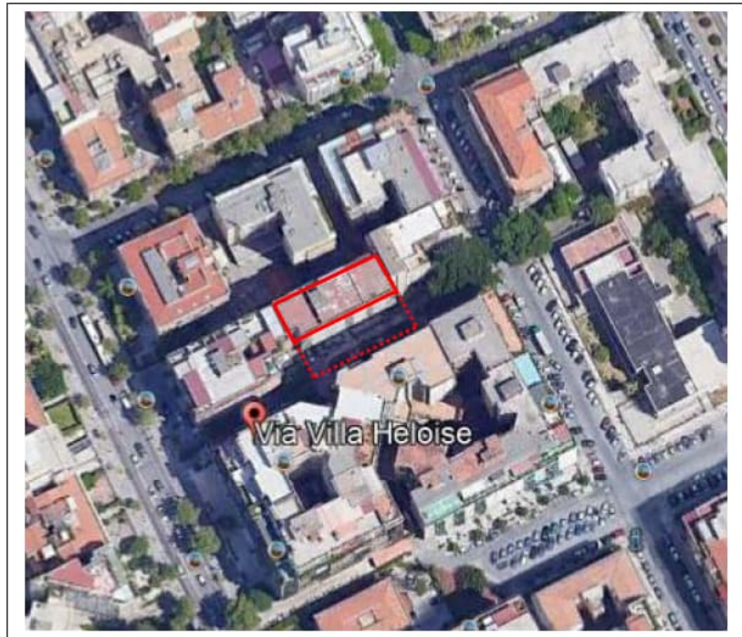
Fig. 3 Foto aerea tratta da Google Earth con indicazione del fabbricato di cui fanno parte i beni pignorati. Con il tratteggio è indicato l'ingombro dei piani seminterrati che si estendono sotto la sede stradale della via Villa Heloise.
