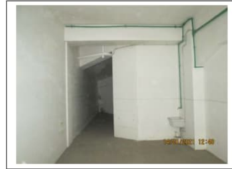
Fig. 25. Primo piano seminterrato. Box auto pignorato identificato al sub. 42. Interno
