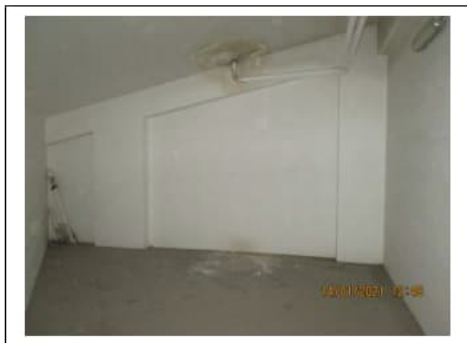
Fig. 26. Primo piano seminterrato. Box auto pignorato identificato al sub. 42. Interno
