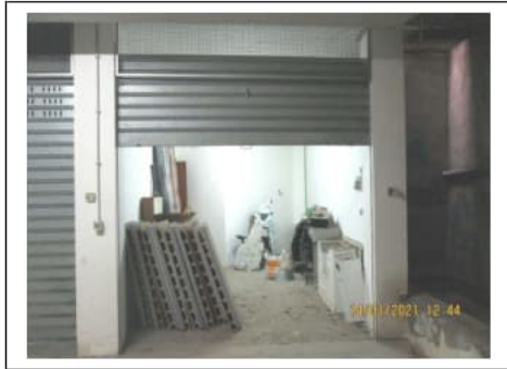
Fig. 24. Primo piano seminterrato. Box auto pignorato identificato al sub. 40
