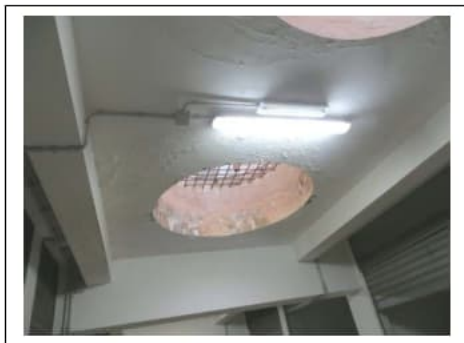
Fig. 20. Primo piano seminterrato. Degradi sul soffitto delle aree di manovra in corrispondenza dei lucernari di via Villa Heloise
