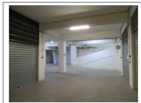
Fig. 15. Primo piano seminterrato. Box auto e corsie di manovra. Sul fondo la rampa di ingresso dal civico n. 38
