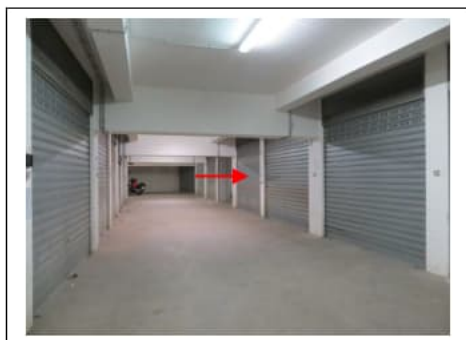
Fig. 24. Primo piano seminterrato. Box auto pignorato identificato al sub. 45
