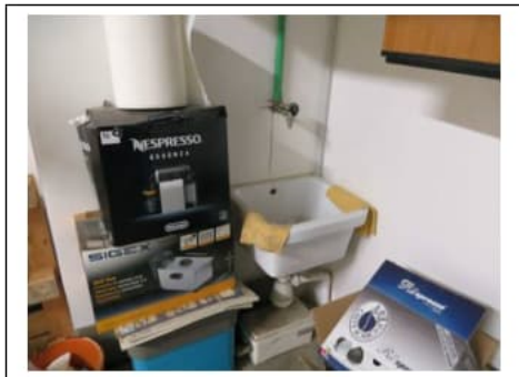
Fig. 28. Primo piano seminterrato. Box auto pignorato identificato al sub. 45. Punto acqua con piletta
