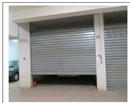
Fig. 25. Primo piano seminterrato. Box auto pignorato identificato al sub. 45
