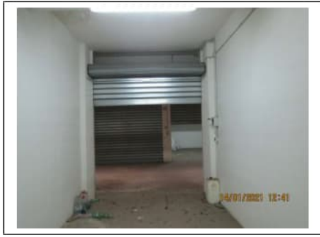
Fig.26. Primo piano seminterrato. Box auto pignorato identificato al sub. 35. Interno.
