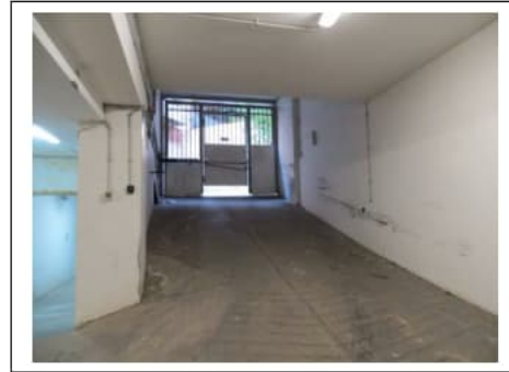
Fig. 11. Rampa del primo piano scantinato con ingresso dal civico n. 22 di via Villa Heloise
