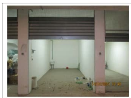
Fig. 25. Primo piano seminterrato. Box auto pignorato identificato al sub. 35
