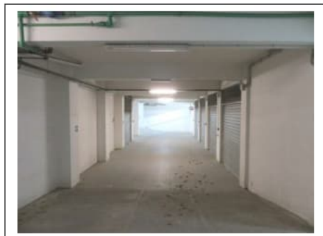
Fig. 14. Primo piano seminterrato. Box auto e corsie di manovra
