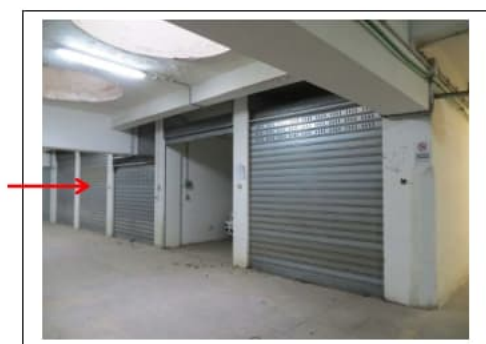
Fig. 24. Primo piano seminterrato. Box auto pignorato identificato al sub 35 (indicato con la freccia)
