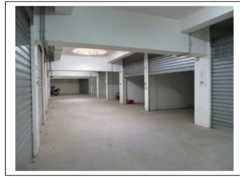
Fig. 19. Primo piano seminterrato. Box auto e corsie di manovra
