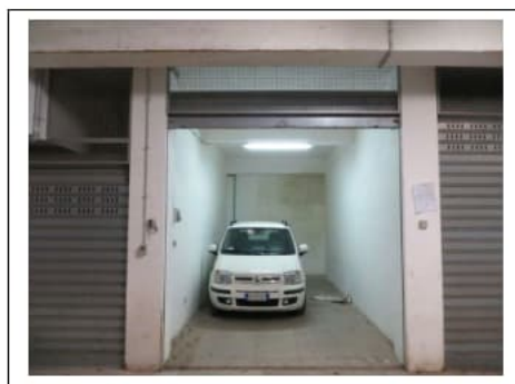
Fig. 25. Primo piano seminterrato. Box auto pignorato identificato al sub. 33
