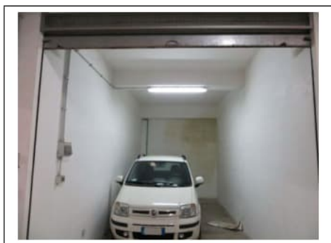
Fig.26. Primo piano seminterrato. Box auto pignorato identificato al sub. 33. Interno.
