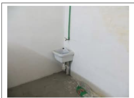
Fig. 28. Primo piano seminterrato. Box auto pignorato identificato al sub. 33. Piletta con punto acqua
