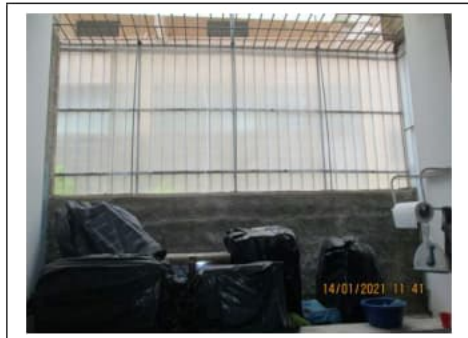
Fig. 28. Primo piano seminterrato. Box auto pignorato identificato al sub. 27. Pannelli in policarbonato protetti da grate a confine con l'intercapedine sul lato nord-ovest
