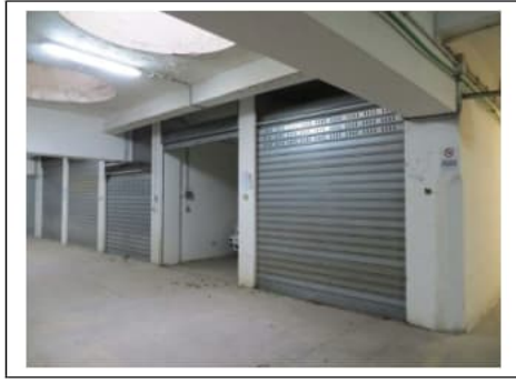
Fig. 18. Primo piano seminterrato. Box auto e corsie di manovra
