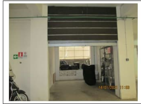
Fig. 25. Primo piano seminterrato. Box auto pignorato identificato al sub. 27
