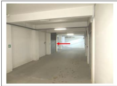
Fig. 24. Primo piano seminterrato. Box auto pignorato identificato al sub. 27 (indicato con la freccia)
