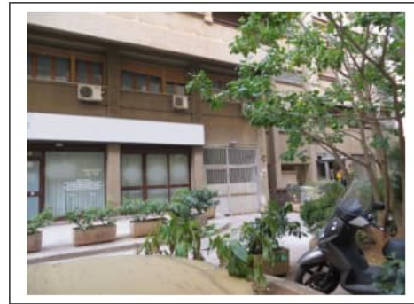
Fig. 7. La via Villa Heloise. Prospetto dell'edificio B dove sono ubicati gli accessi delle rampe del primo e secondo piano scantinato
