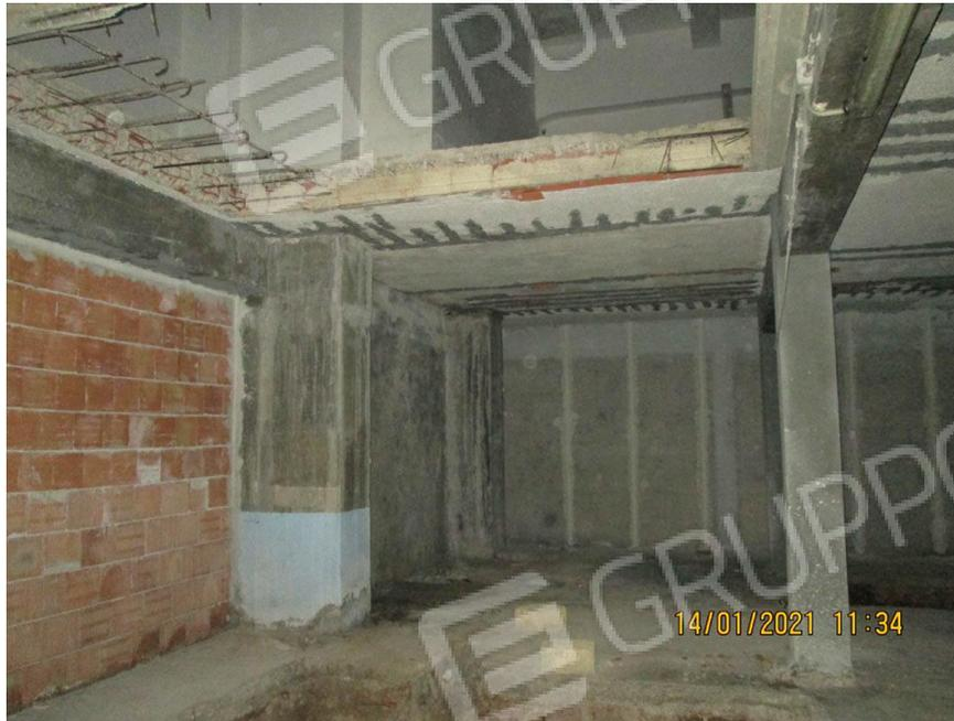
**Foto 13.** Secondo piano scantinato. Foro su solaio di interpiano nell'angolo nord-est dell'autorimessa
