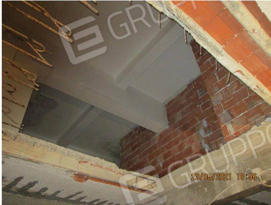
**Foto 15.** Secondo piano scantinato. Foro su solaio di interpiano nell'angolo nord-est dell'autorimessa
