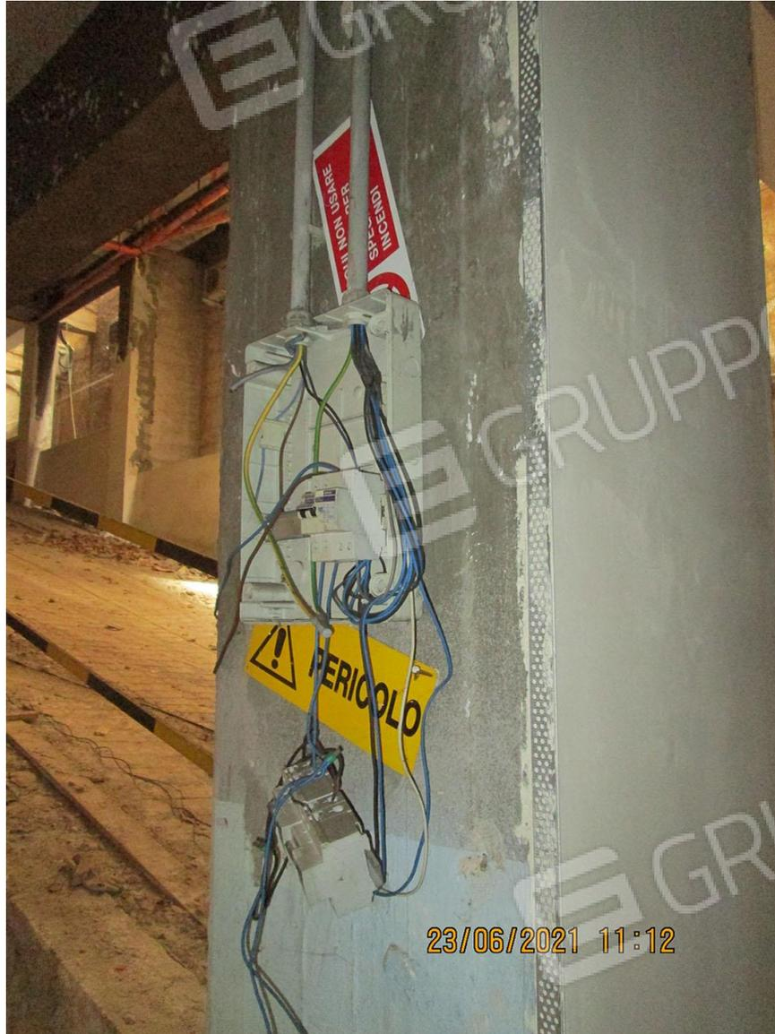
Foto 49. Quadro elettrico in fase di costruzione
