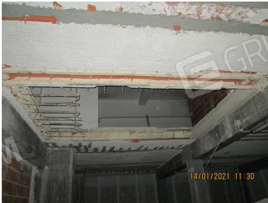
**Foto 14.** Secondo piano scantinato. Foro su solaio di interpiano nell'angolo nord-est dell'autorimessa
