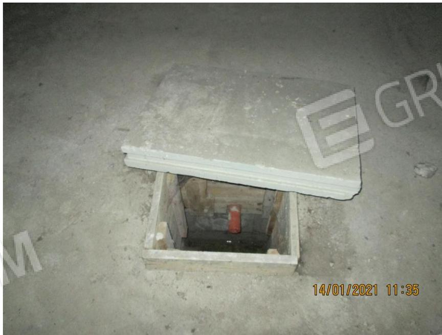
**Foto 48.** Secondo piano scantinato. Pozzetti del sistema fognante
