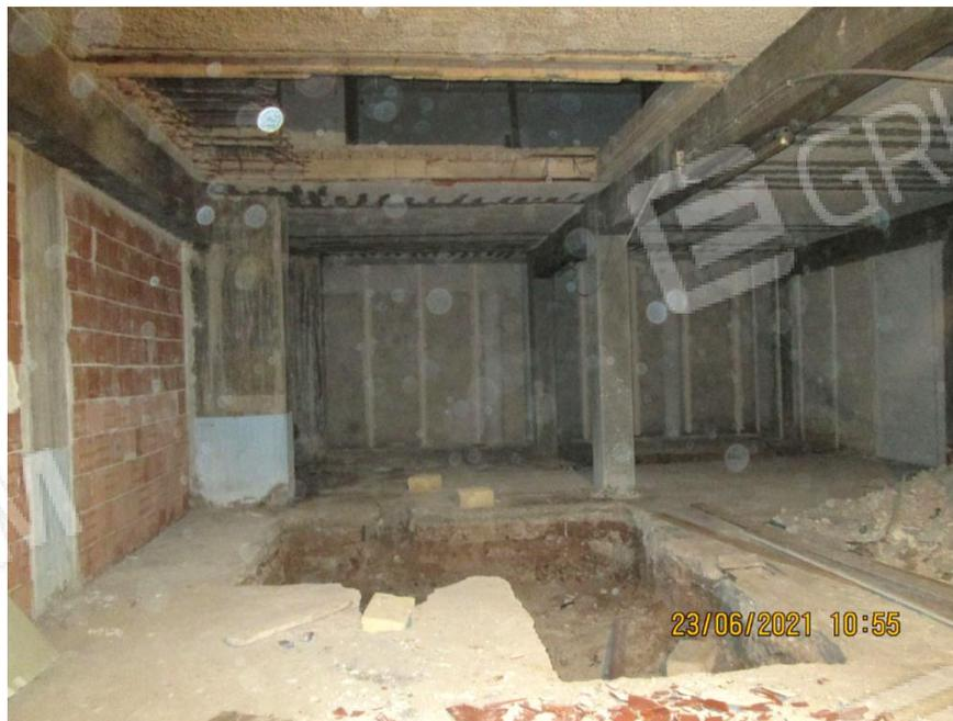
**Foto 12.** Secondo piano scantinato. Foro su solaio di interpiano nell'angolo nord-est dell'autorimessa
