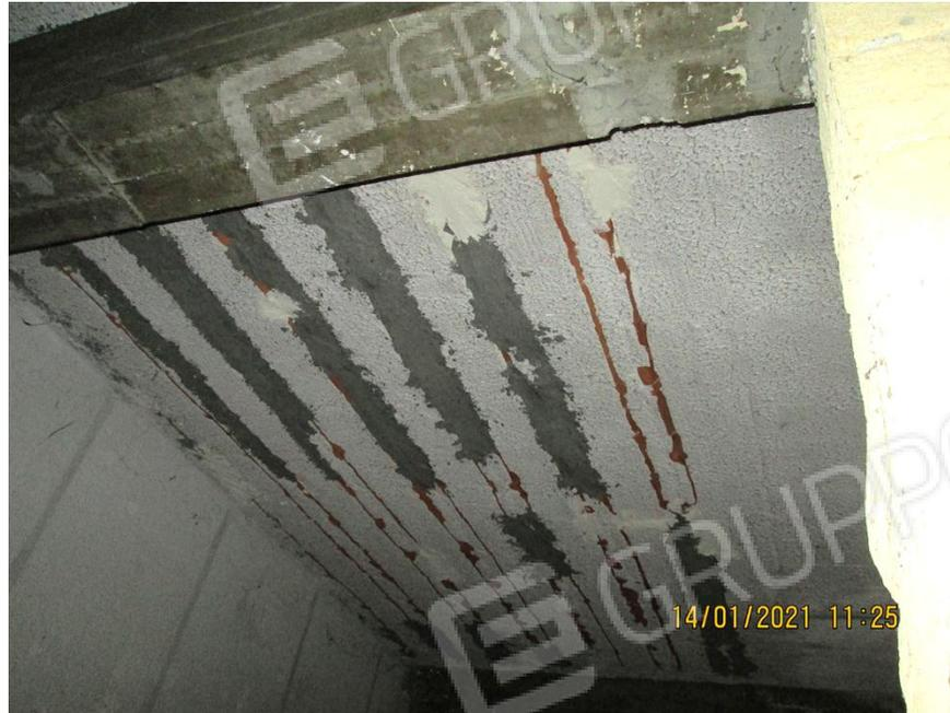
**Foto 33.** Secondo piano scantinato. Box auto. Soffitti deteriorati
