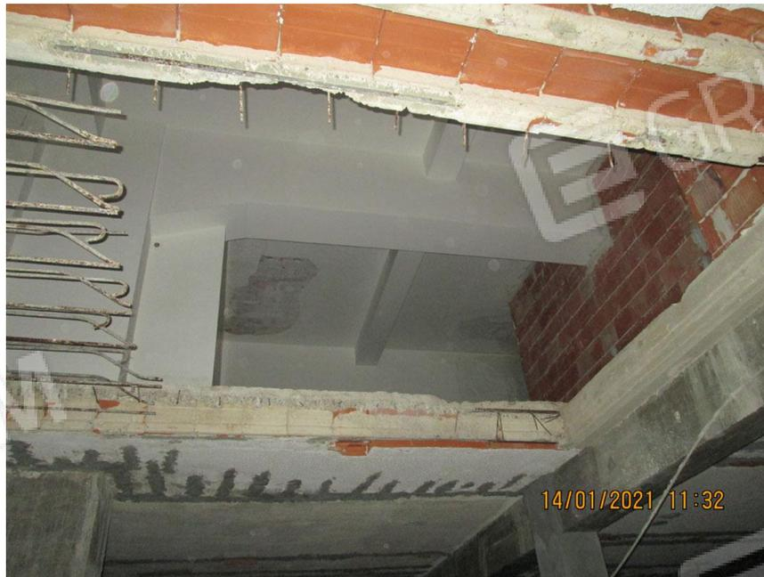
**Foto 16.** Secondo piano scantinato. Foro su solaio di interpiano nell'angolo nord-est dell'autorimessa
