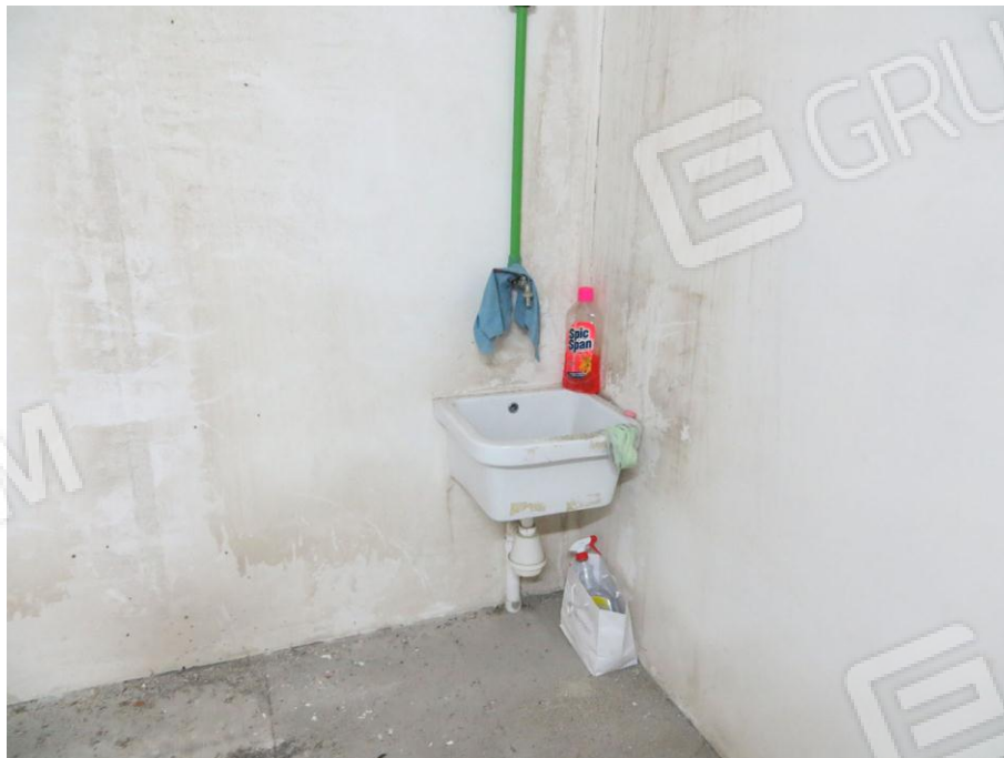
Foto 6. Primo piano seminterrato. Box auto pignorato identificato al sub. 39. Punto acqua con piletta
