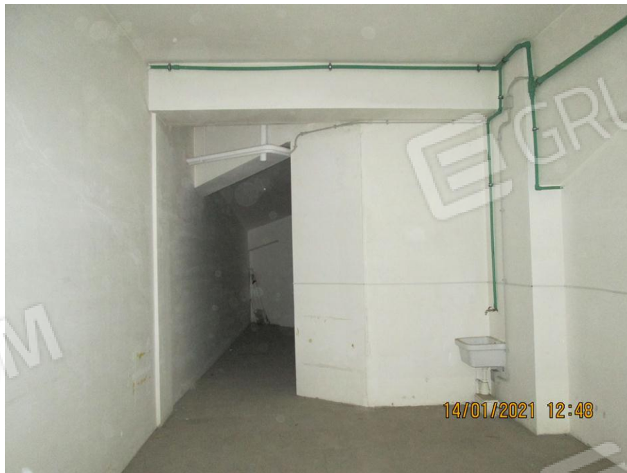
Foto 2. Primo piano seminterrato. Box auto pignorato identificato al sub 42
