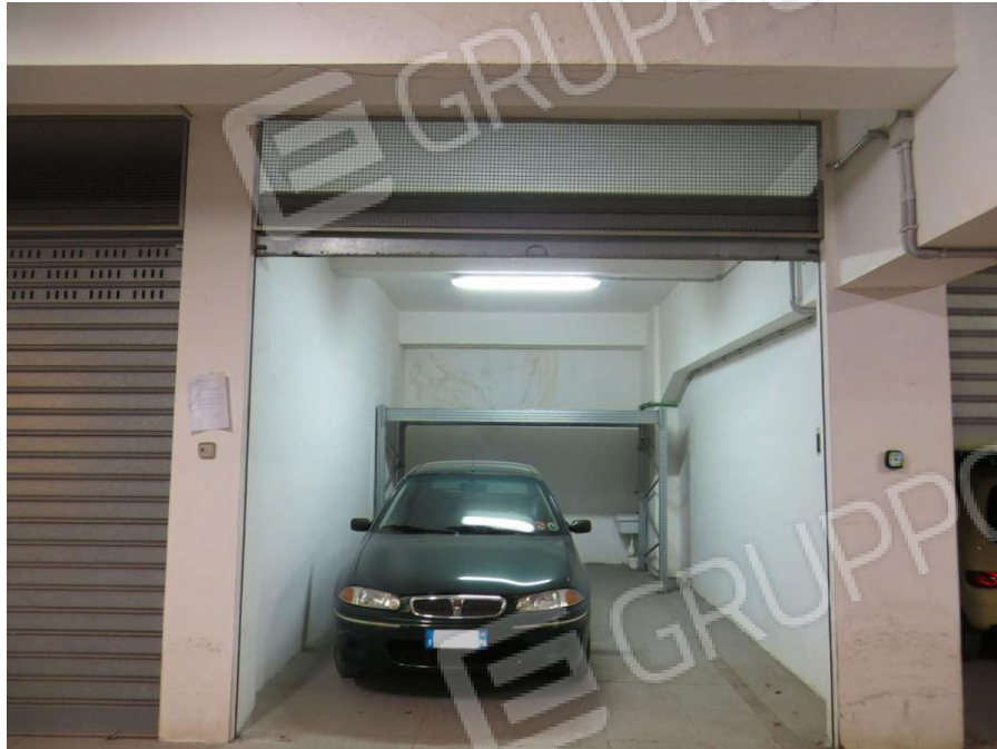
Foto 3. Primo piano seminterrato. Box auto pignorato identificato al sub 46. interno
