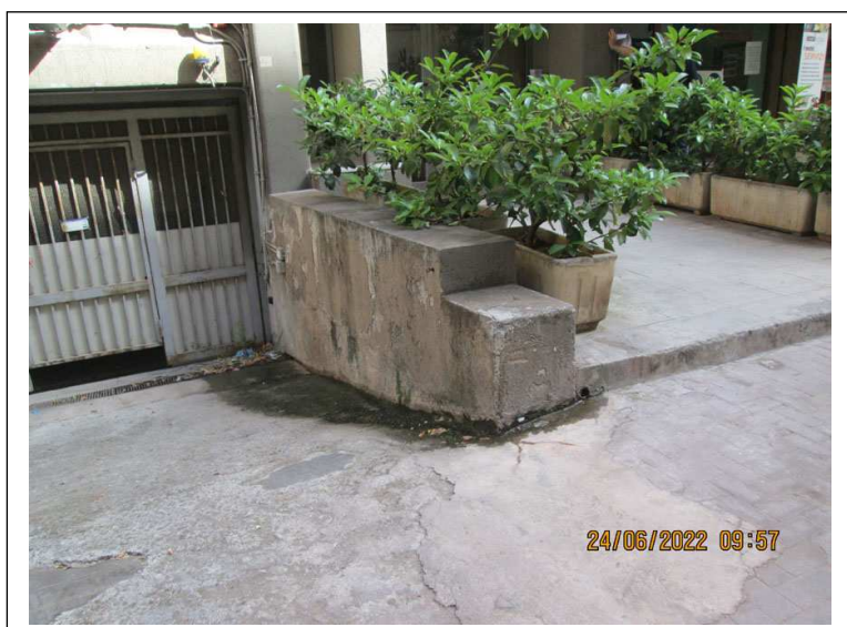
Foto 25. Porzione di rampa a cielo aperto dal civico n. 22 di via Villa Heloise
