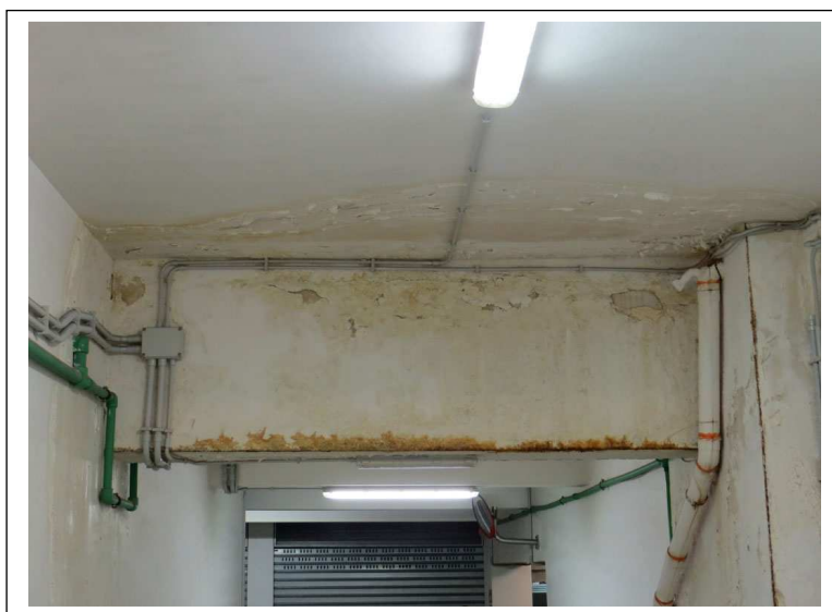
Foto 19. Trave ammalorata della corsia comune compresa tra il box sub. 37 e il box sub. 38
