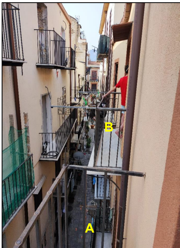
Camera da Letto 2 : (A) Balcone su Vicolo Cristofaro ; (B) Balcone del Pranzo - soggiorno ;
