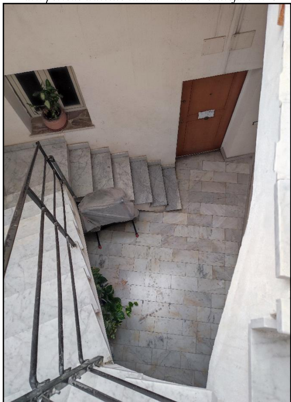
Rampe di accesso al Piano III con chiostrina
