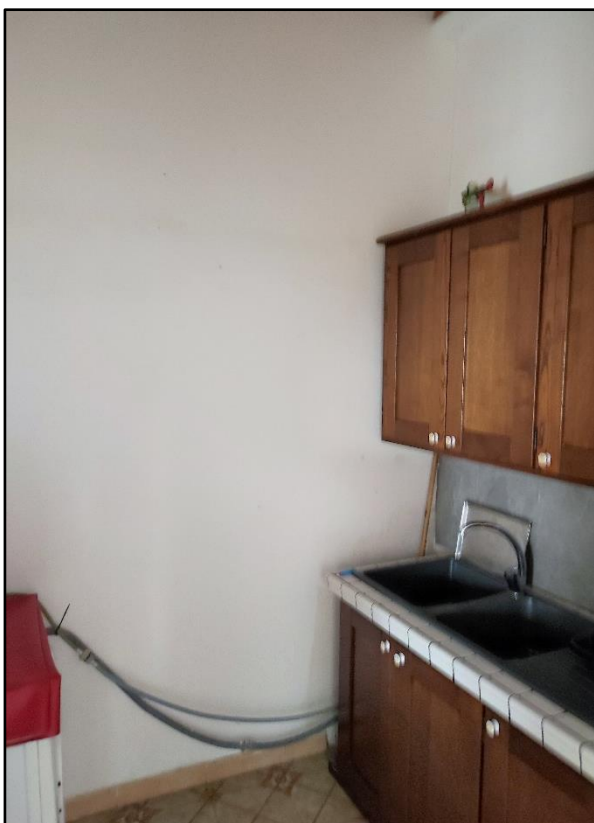
Cucina : particolare top in muratura, rivestito con piastrelle ceramiche ed elementi da incasso in acciaio inox
