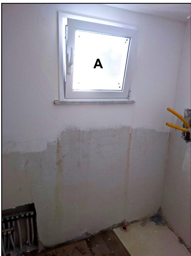
Lavanderia annessa al W.C. : (A) serramento in alluminio anodizzato preverniciato con apertura a vasistas ;
