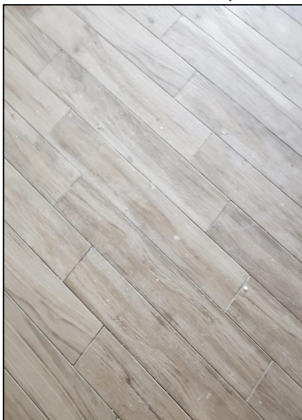
Part. pavimento in listoni di grès porcellanato effetto rovere (formato cm.18 x 90)
