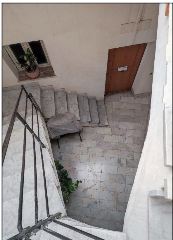
Rampe di accesso al Piano III con chiostrina
