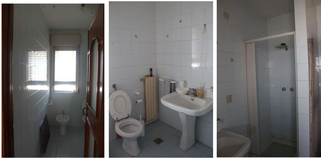
w.c. esposto su balcone di retrospetto (Vano 10)
