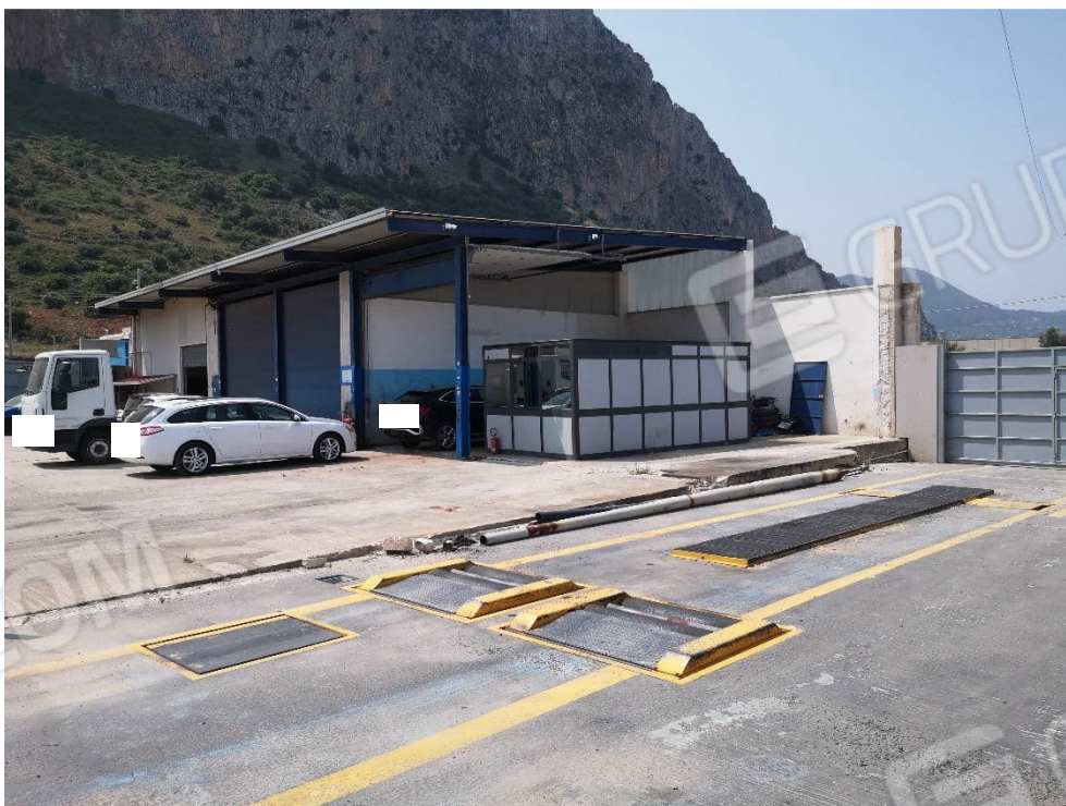
2. Area lavorazioni (confine profilo nord tettoia circa corrispondente a confine p.lla catasto terreni 1107)
