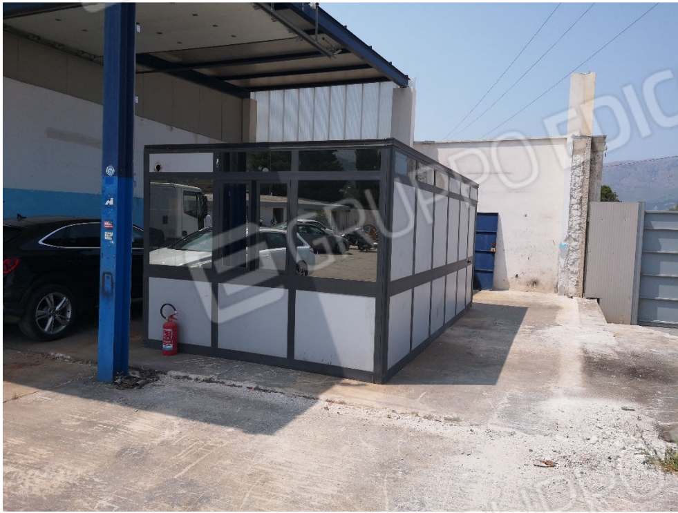
5. Prefabbricato a nord dell'area di lavorazione
