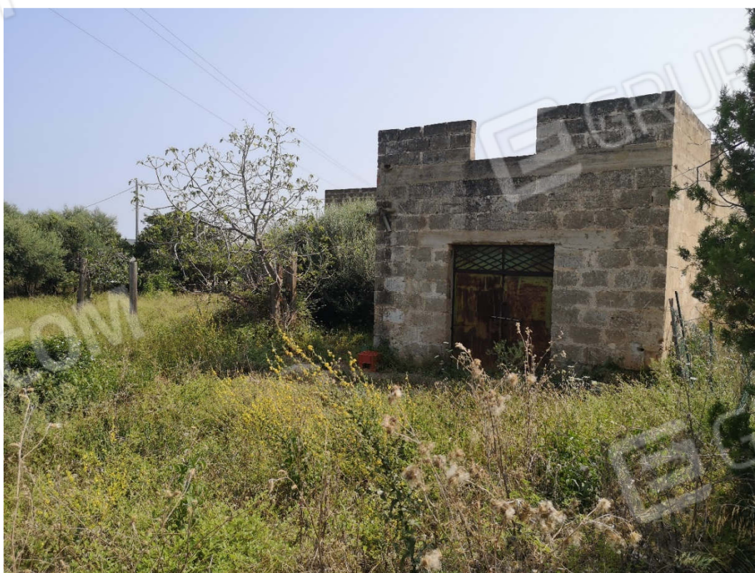
2. Accesso ovest da corte
