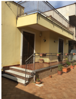
Rilievo fotografico del 09.03.2020
