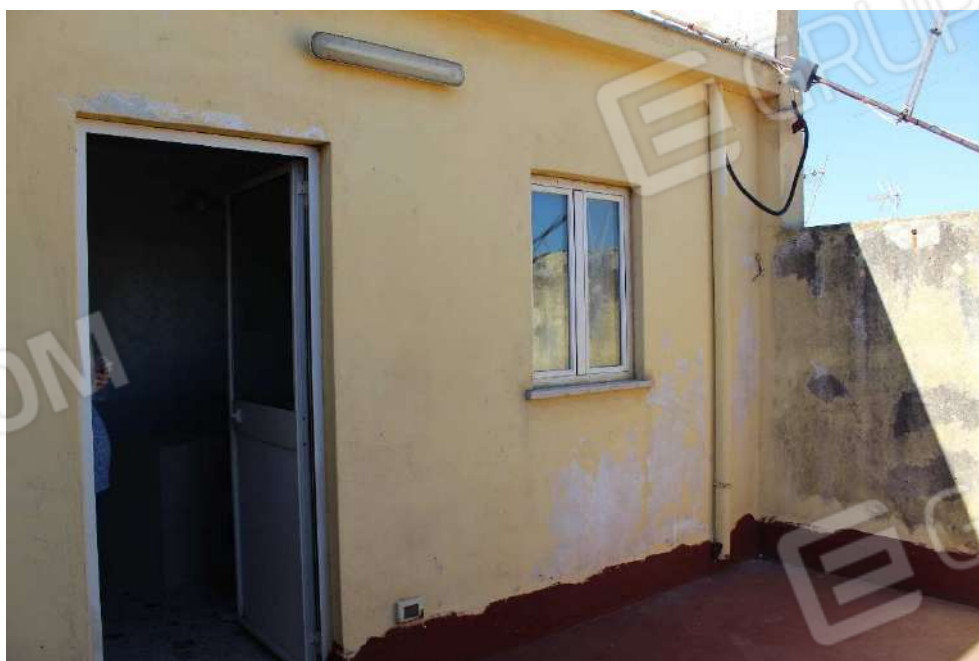
Foto n. 26 – Prospetto rientrato su Via Aguglia. (piano terzo).
