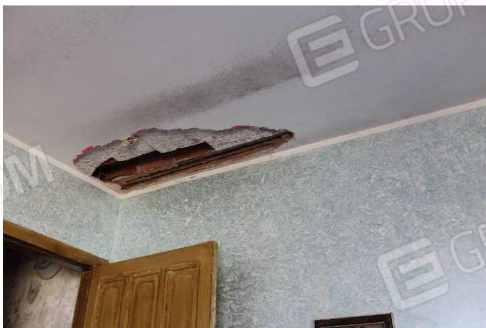
Foto n. 32 – Camera al piano terzo: intradosso solaio di copertura.
