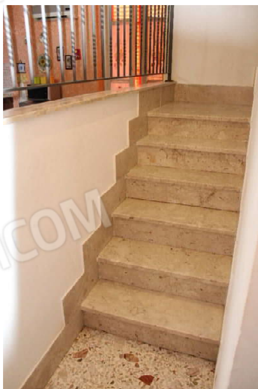
Foto n. 12 – Vano scala, seconda rampa.
