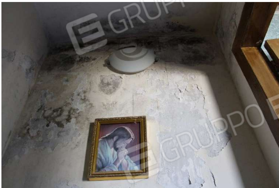
Foto n. 31 – Vano scala, ultima rampa (Terzo piano): Parete confinante con altra proprietà:.
