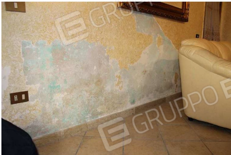
Foto n. 29 – Soggiorno (Piano Terra): parete a confine del vano scala .
