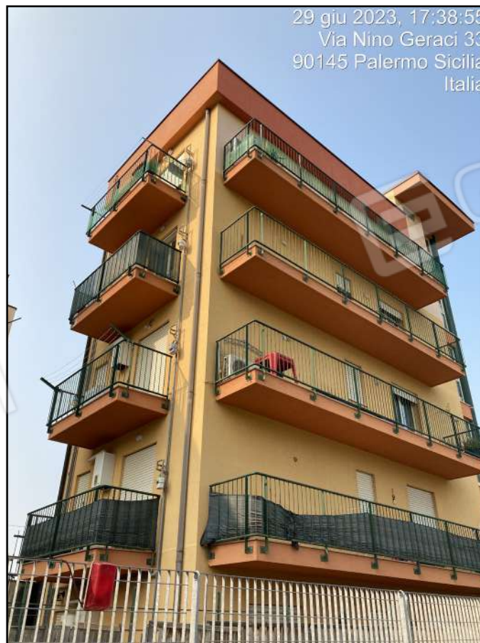
Foto n. 8 - Vista esterna Edificio Scala B
