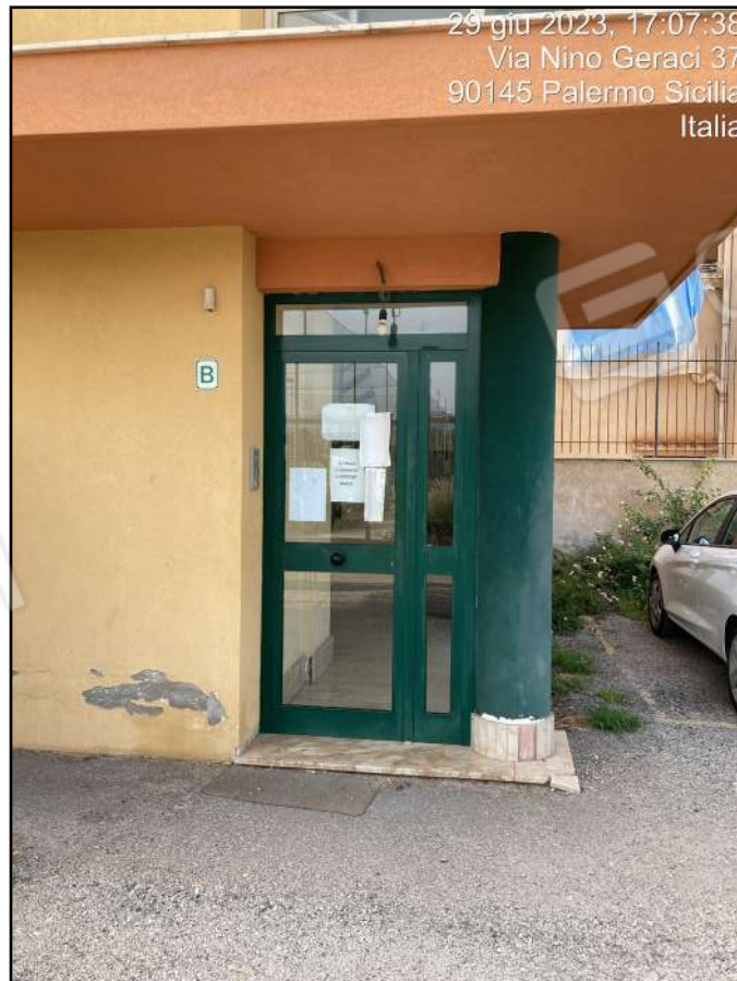
Foto n. 10 - Vista esterna Edificio Scala B
