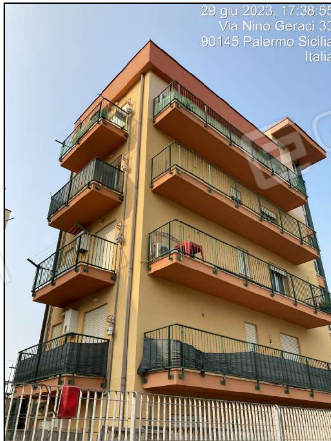
Foto n. 8 - Vista esterna Edificio Scala B
