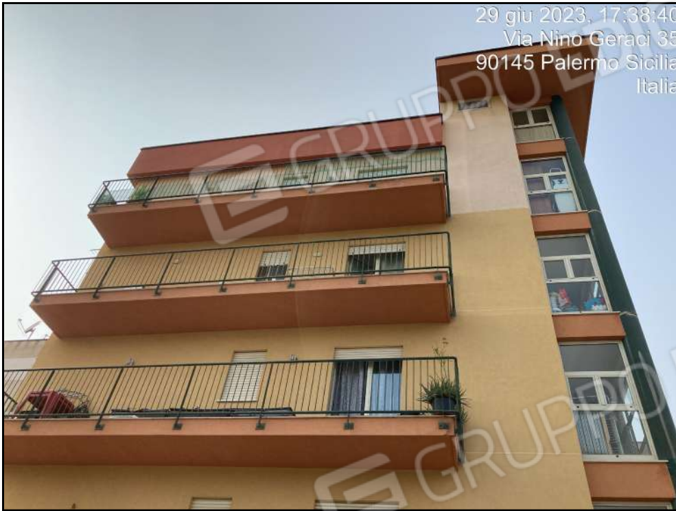
Foto n. 7 - Vista esterna Edificio Scala B
