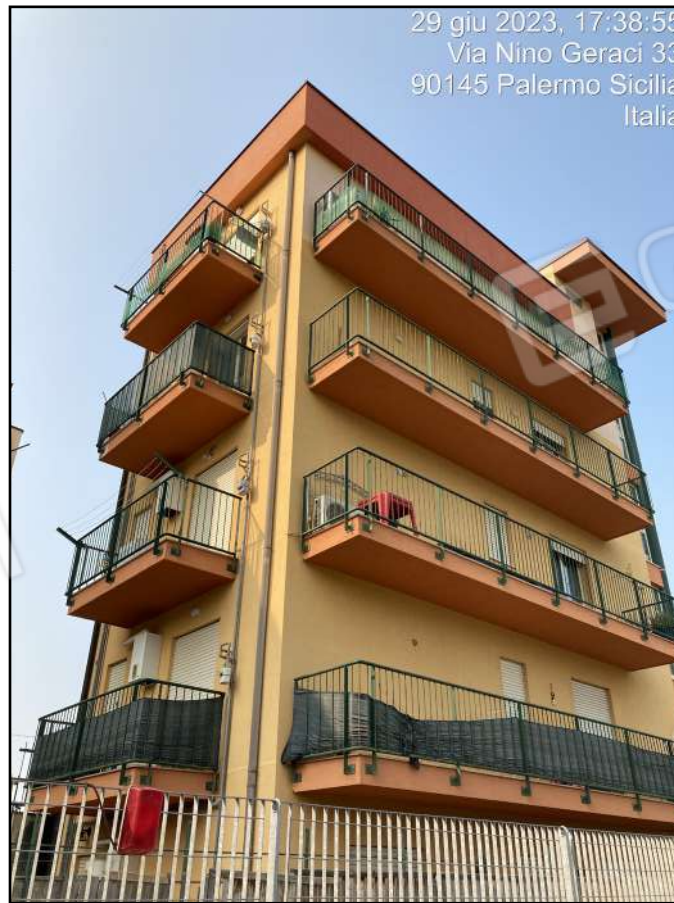
Foto n. 8 - Vista esterna Edificio Scala B
