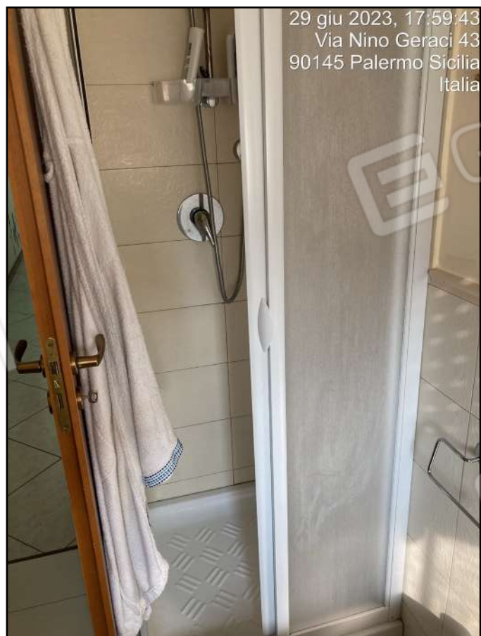
Foto n. 18 - Interni: w.c. con doccia
