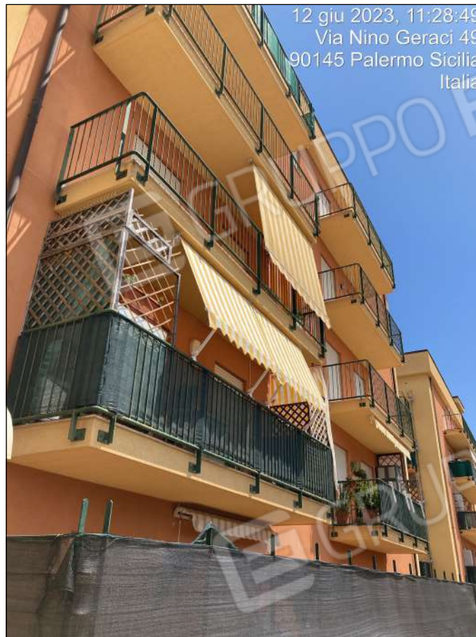
Foto n. 7 - Vista esterna Edificio Scala C
