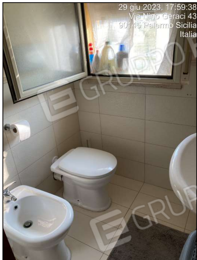
Foto n. 17 - Interni: w.c. con doccia
