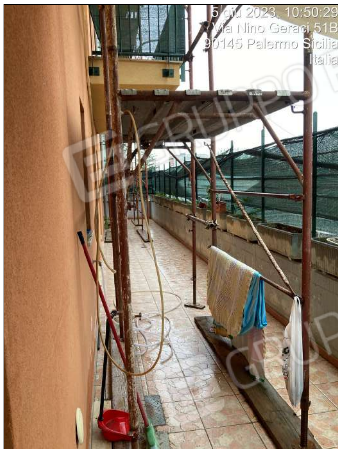
Foto n. 25 - Esterni: corte di pertinenza
