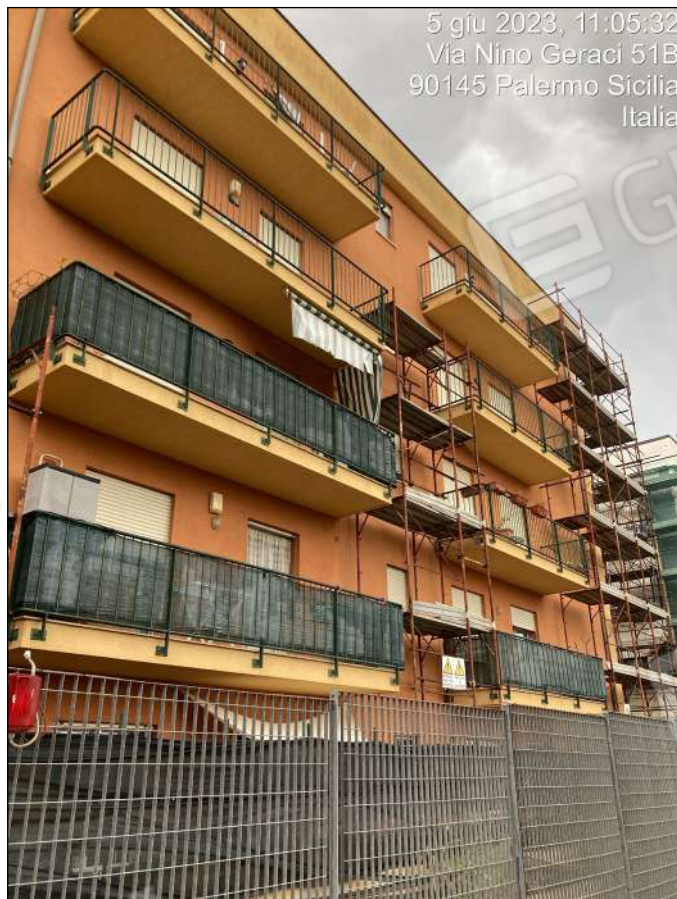
Foto n. 8 - Vista esterna Edificio Scala D
