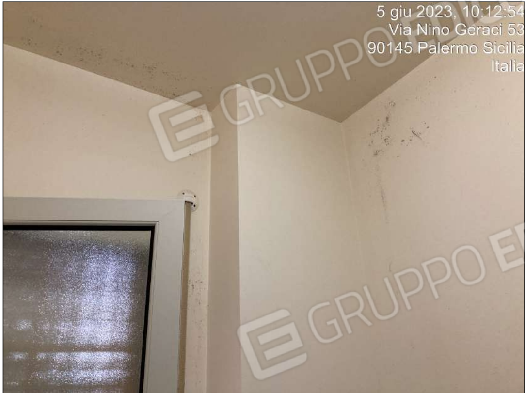
Foto n. 25 - Interni: segni di umidità da condensa nel w.c. doccia
