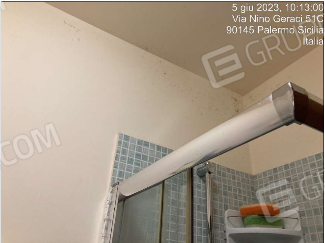
Foto n. 26 - Interni: segni di umidità da condensa nel w.c. doccia
