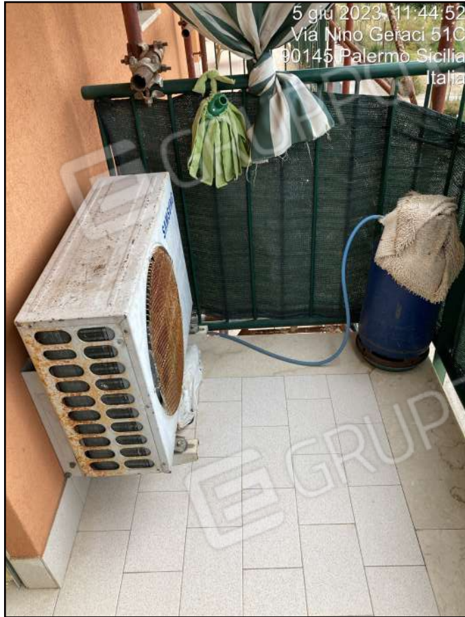
Foto n. 27 - Interni: balcone della cucina
