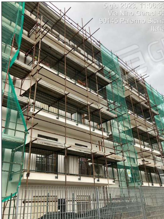
Foto n. 8 - Vista esterna Edificio Scala E
