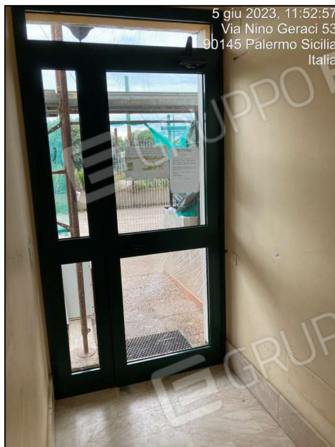
Foto n. 9 - Ingresso Edificio Scala E
