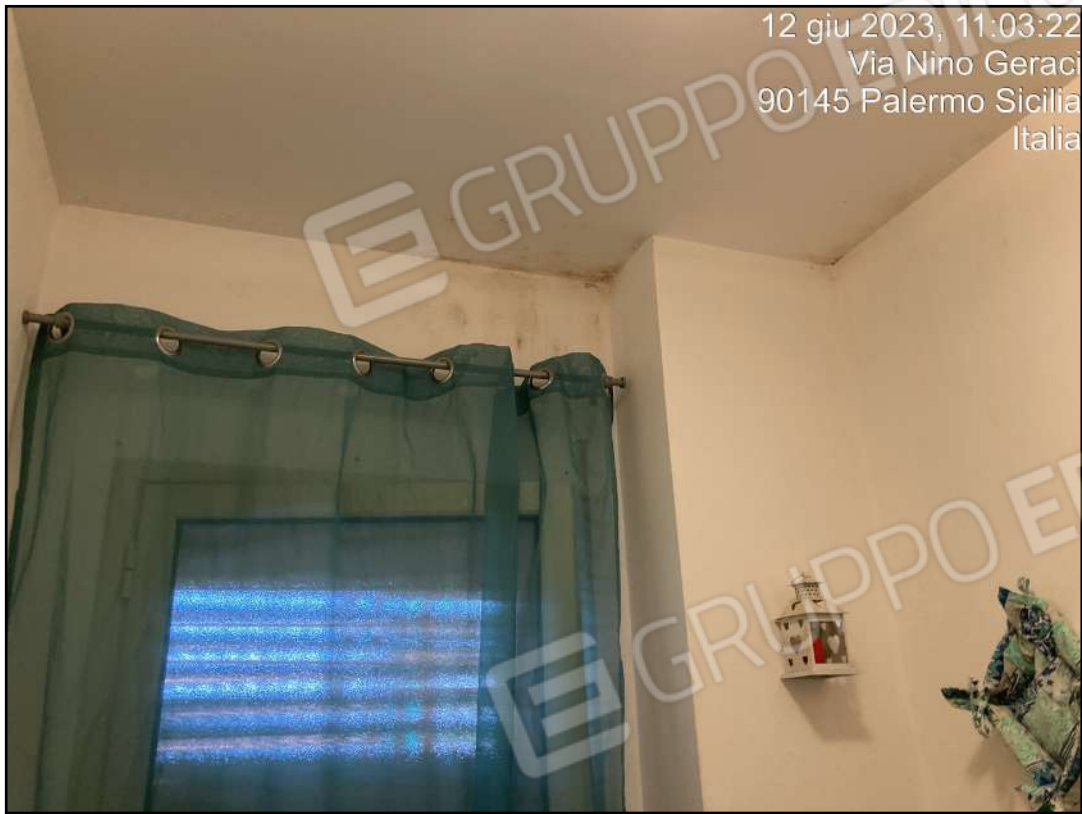
Foto n. 23 - Interni: w.c. doccia, interno alla camera da letto - segni di condensa
