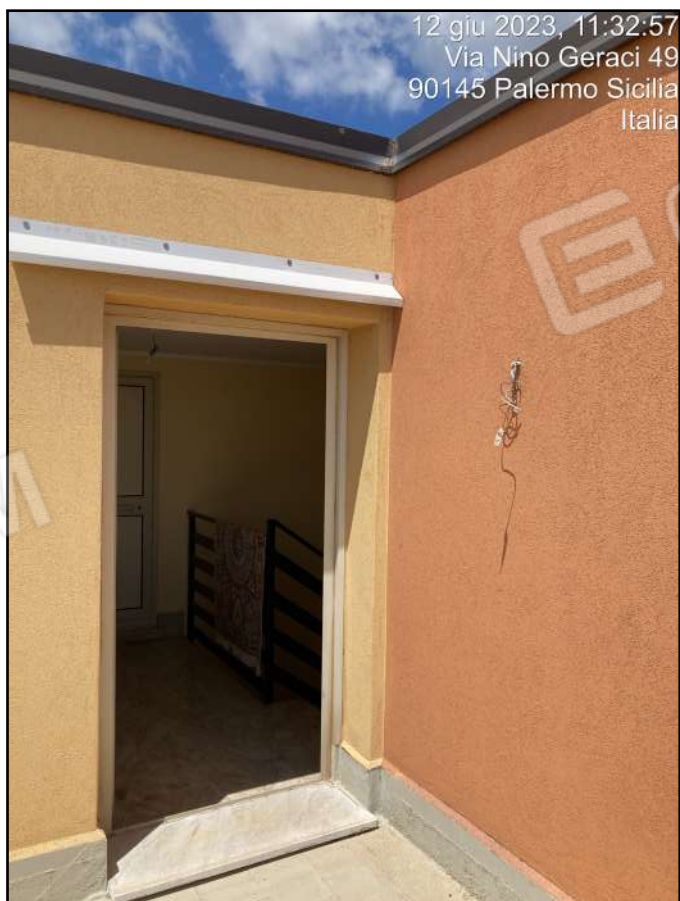
Foto n. 10 - Accesso al terrazzo da corpo scala
