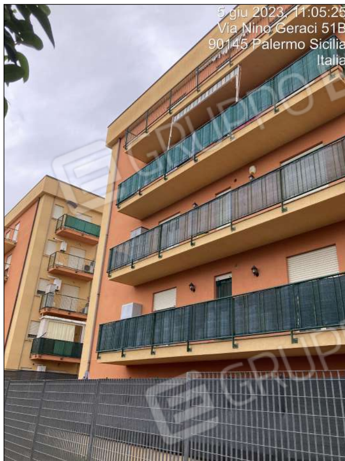
Foto n. 7 - Vista esterna Edificio Scala D
