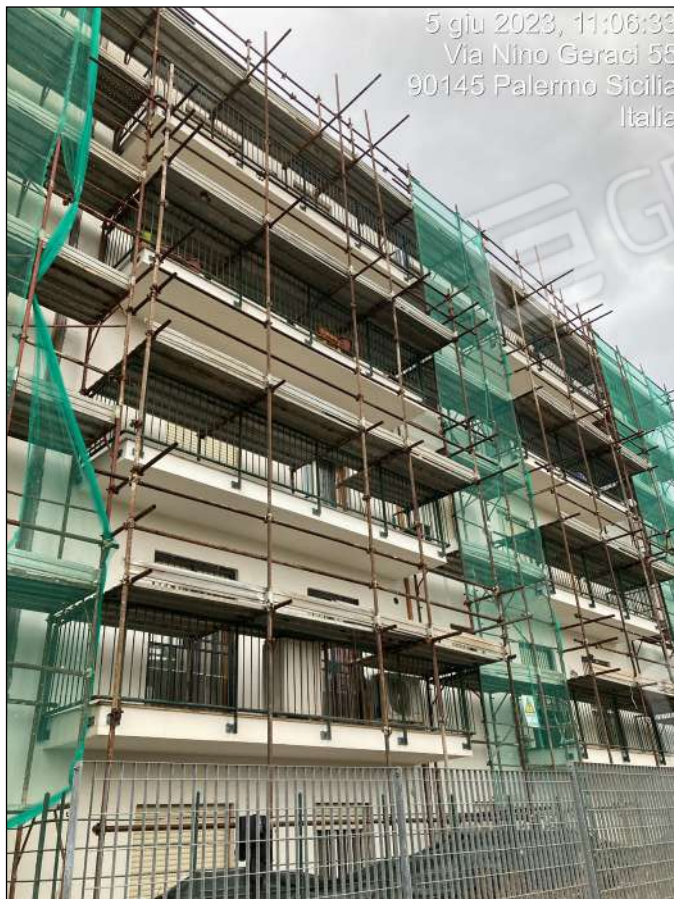
Foto n. 8 - Vista esterna Edificio Scala E
