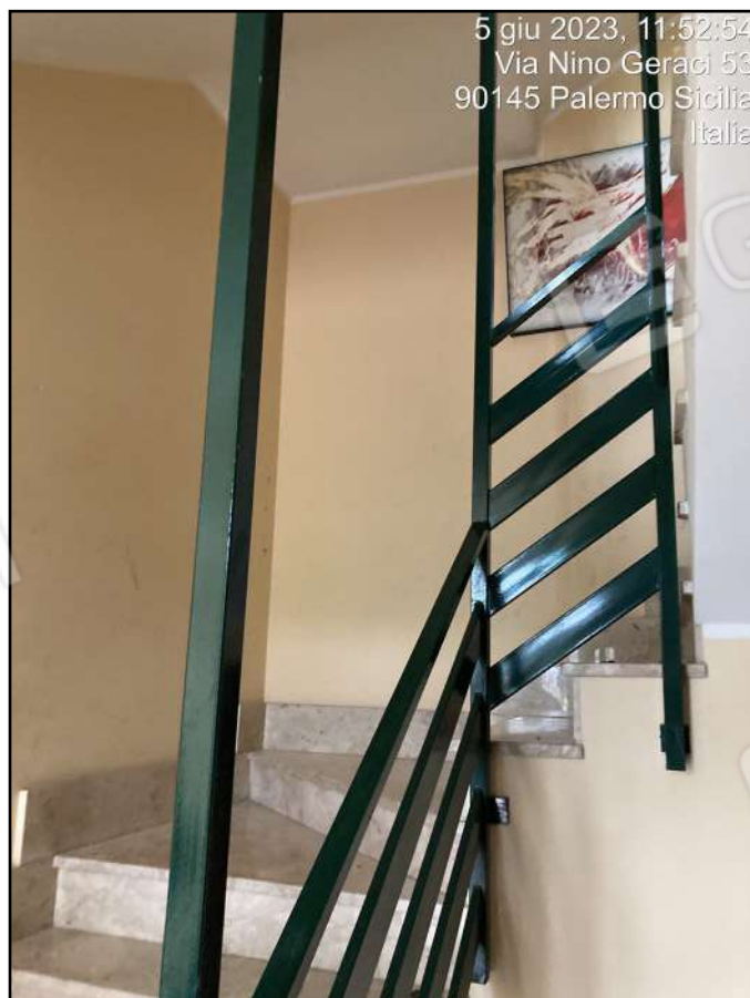
Foto n. 10 - Corpo scala Scala E
