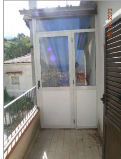
Foto 16 – Vano lavanderia nel balcone su fronte sud
