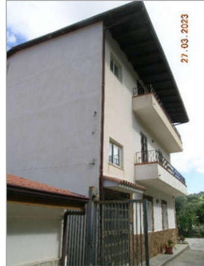
Foto 4 – Prospetto principale dell'edificio
