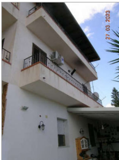
Foto 7 – Retrospetto su fronte est
