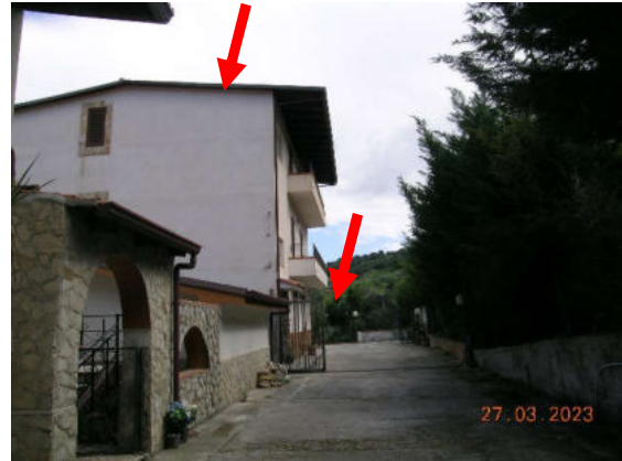
Foto 2 – Cancelli sulla p.la 336 di accesso all'area di sedime del fabbricato
