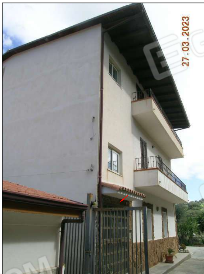
Prospetto principale dell'edificio
