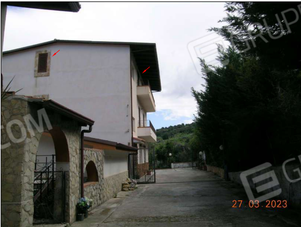
Cancello sulla particella 336 di accesso all'area di sedime del fabbricato
