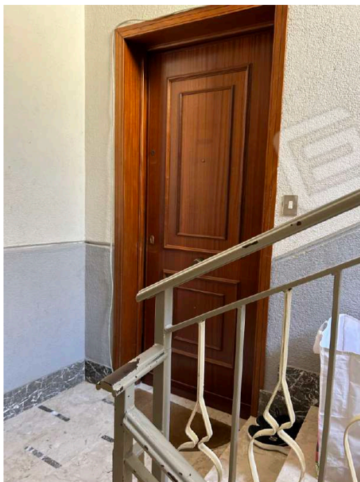
Foto n. 02 - Porta di ingresso all'immobile
