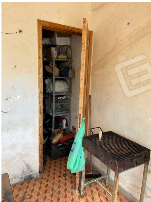
Foto n. 14 - Porta di ingresso al piccolo vano ripostiglio di pertinenza all'immobile
