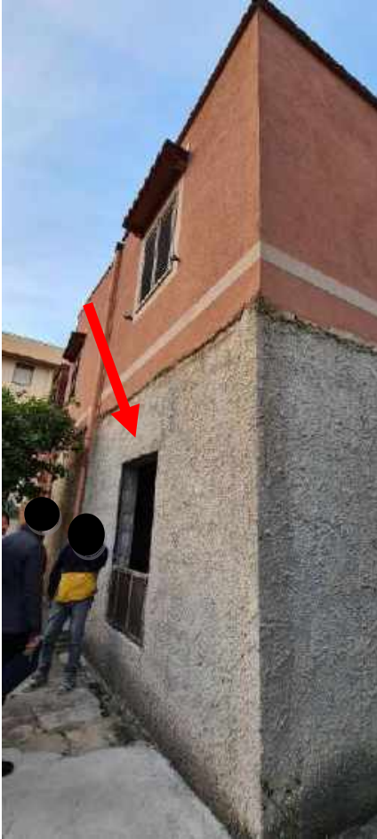
Servizio igienico ubicato nel sottoscala
