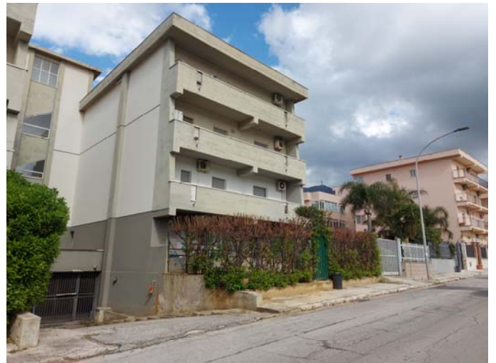
3. INGRESSO DA VIA RAGAZZI DEL '99
