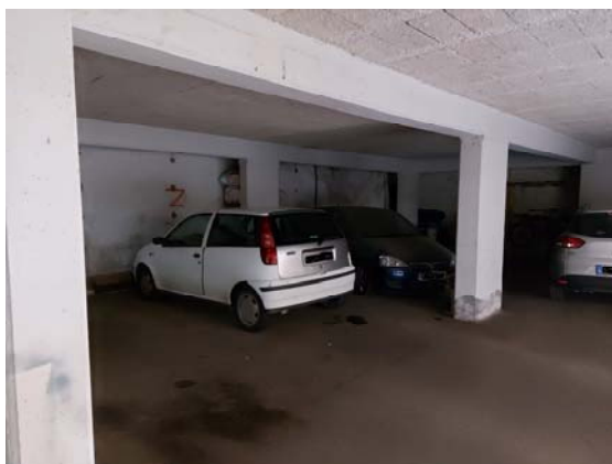
24. POSTO AUTO PIANO INTERRATO
