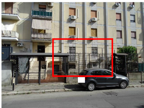
Edificio sito in via Giuseppe Cammarano n.15. Individuazione della u.i. pignorata.
