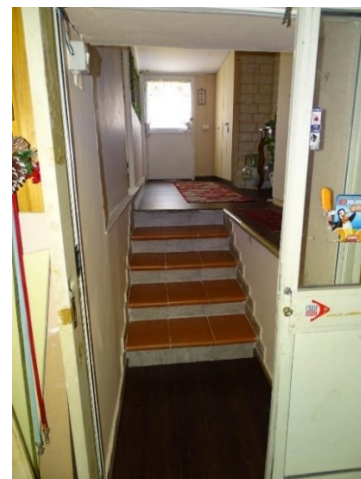
Rampa di scale che consente l'accesso diretto all'ampliamento della cantina dalla veranda.
