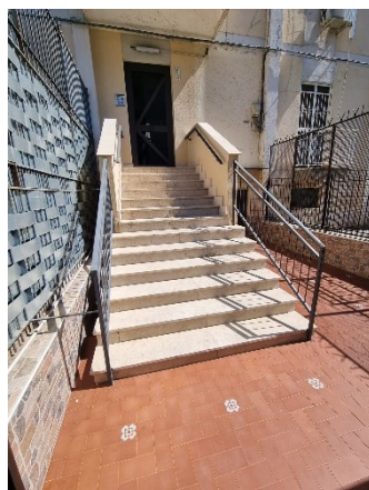
Accesso all'androne condominiale
