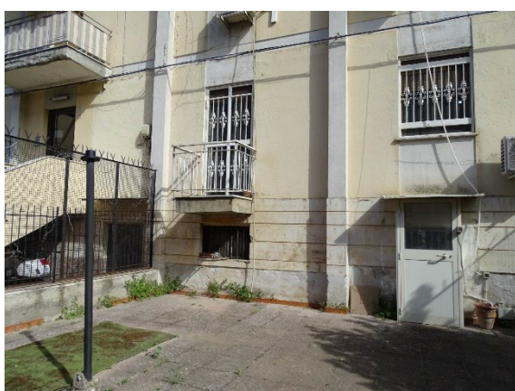
Area scoperta di pertinenza della u.i. pignorata, sul prospetto principale
