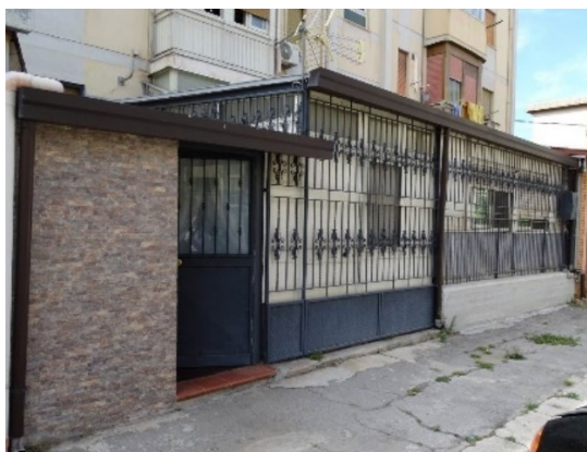
Retrospetto. Vista della veranda e del portoncino di ingresso dall'esterno.
