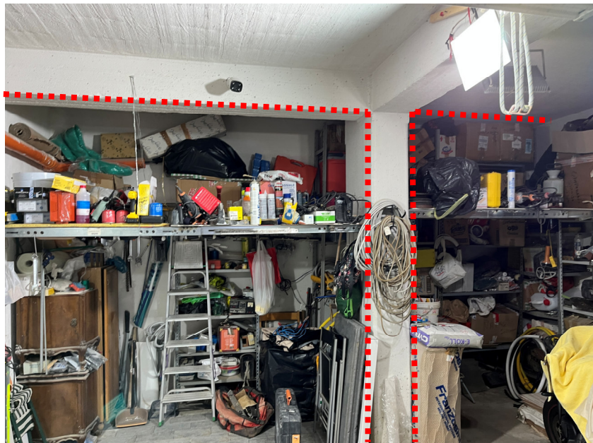
Foto 20 - box auto (assenza del setto murario che funge da intercapedine fondale)
