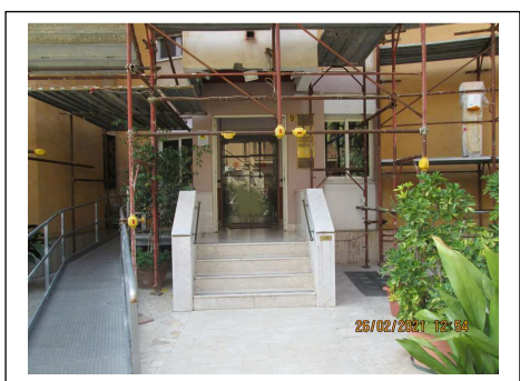
Foto 3. Portone di ingresso al fabbricato di cui fa parte l'immobile pignorato dal civico n. 9 di Viale Regina Margherita
