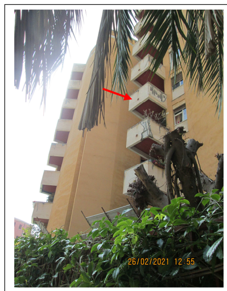
Foto 2. Il prospetto su Viale Regina Margherita del fabbricato di cui fa parte l'immobile pignorato. Con la freccia rossa è indicato il balcone dell'immobile
