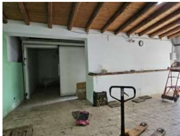
Foto n. 3 Vista interna dell'immobile
