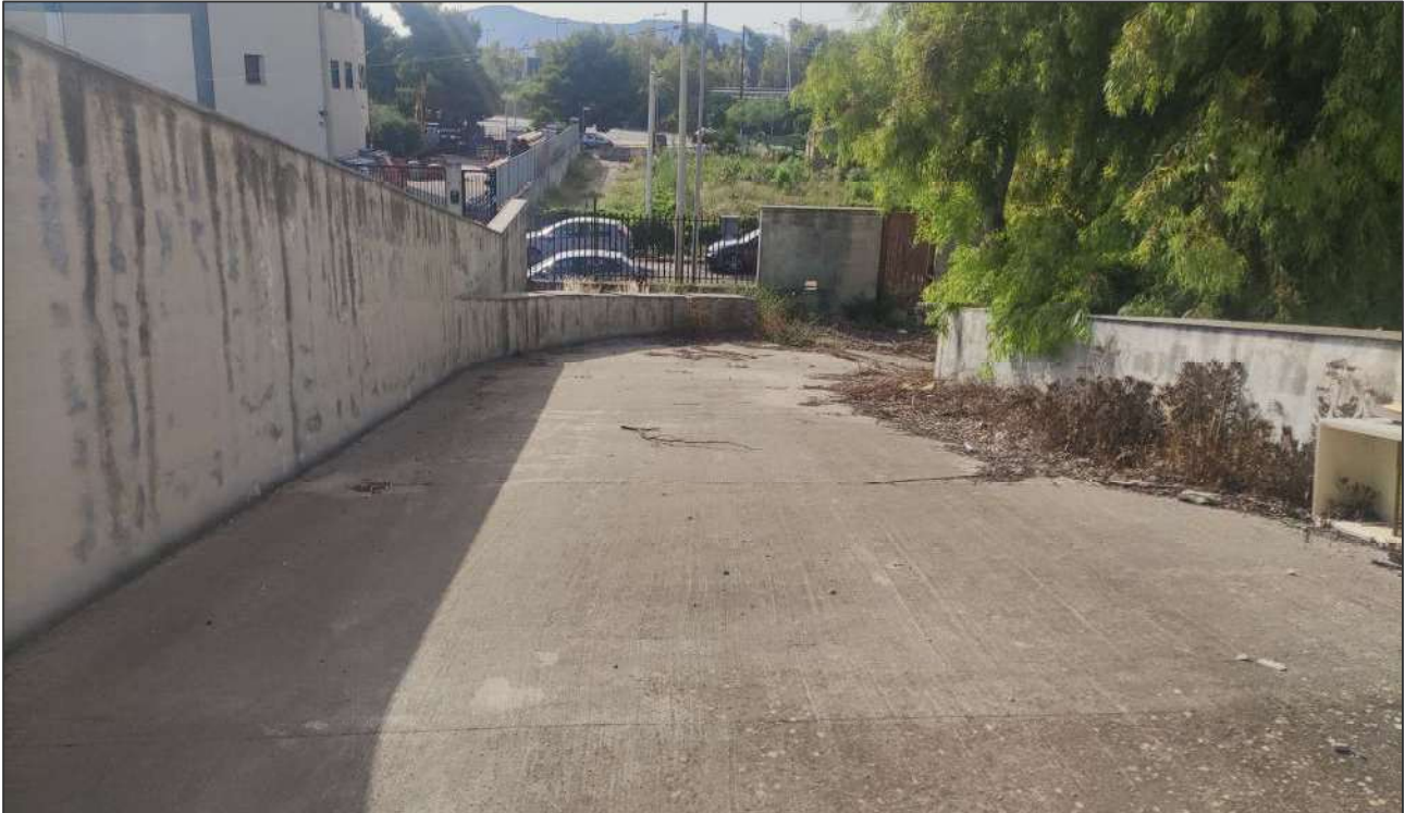
La rampa di accesso al piano
