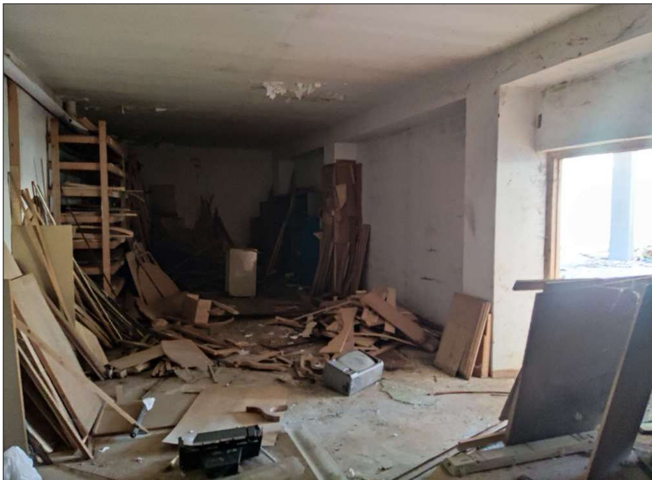
Vano adibito a deposito
