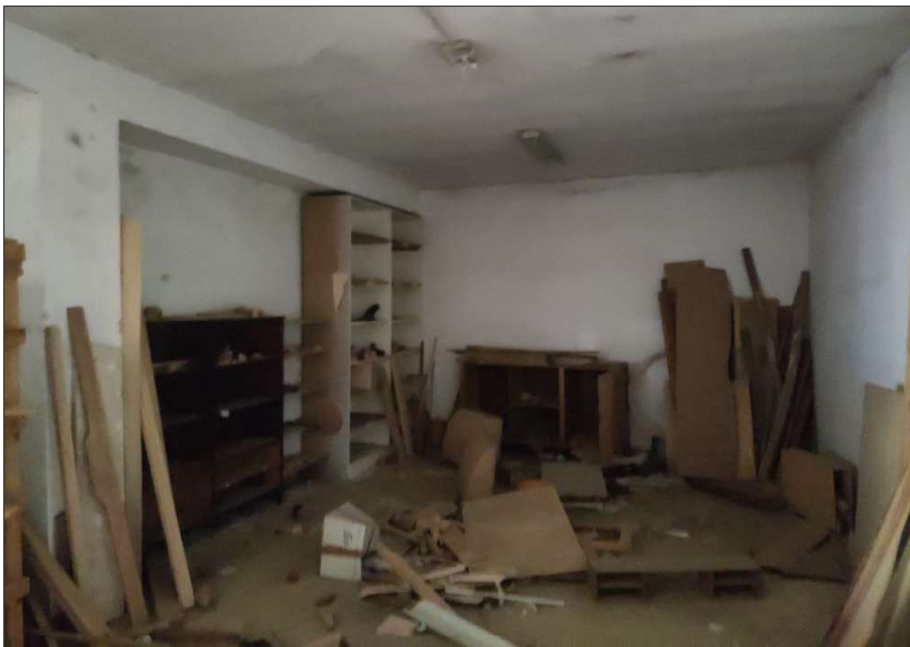
Vano adibito a deposito
