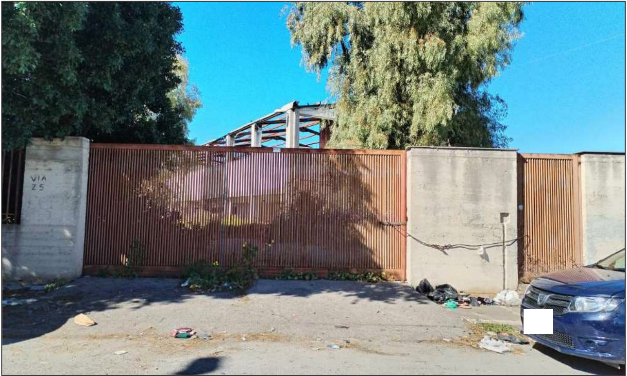
Ingressi, pedonale e carrabile, sulla via R. Livatin, a ridosso del corpo di fabbrica A (oggetto della procedura)
