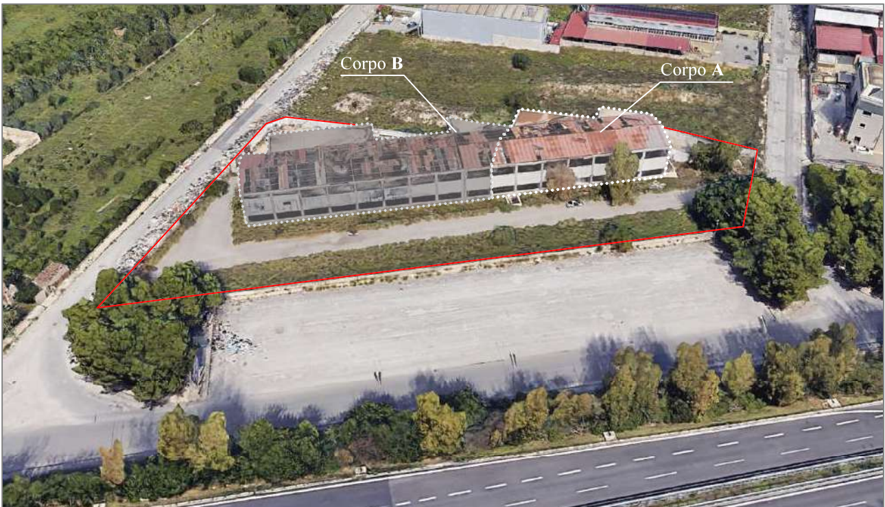
Visioni d'insieme del complesso di Fondo La Rosa. Nella foto sono ancora visibili "tracce" dei pannelli di copertura oggi totalmente assenti.
