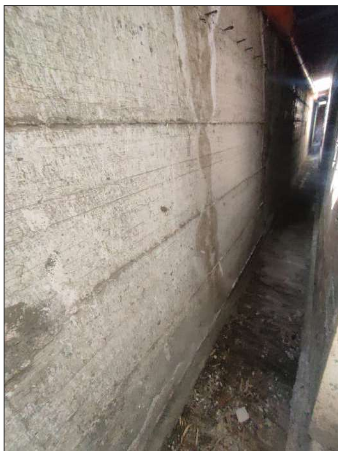
Indiana ispezionabile posta sul alto lungo esposto a sud
