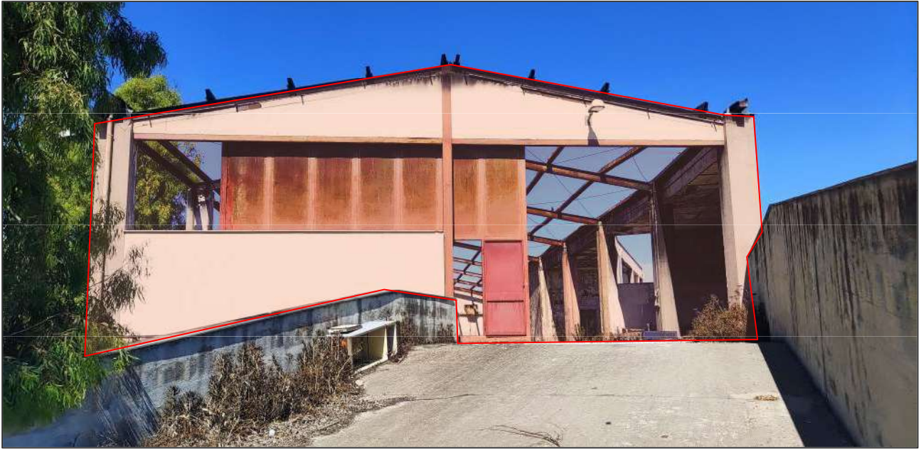
Prospetto ad est. (Corpo A)
