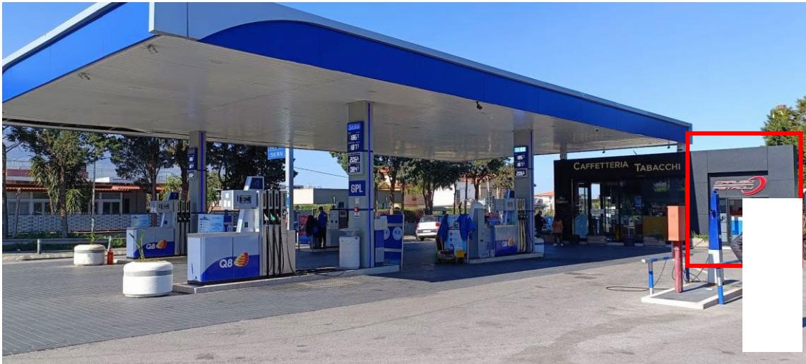
In rosso: locale tecnico adiacente il bar /tabaccheria autorizzato come pergolato e chiuso invece con infissi
