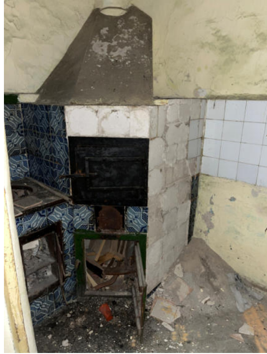
Foto 5 - piano terra - Cucina
