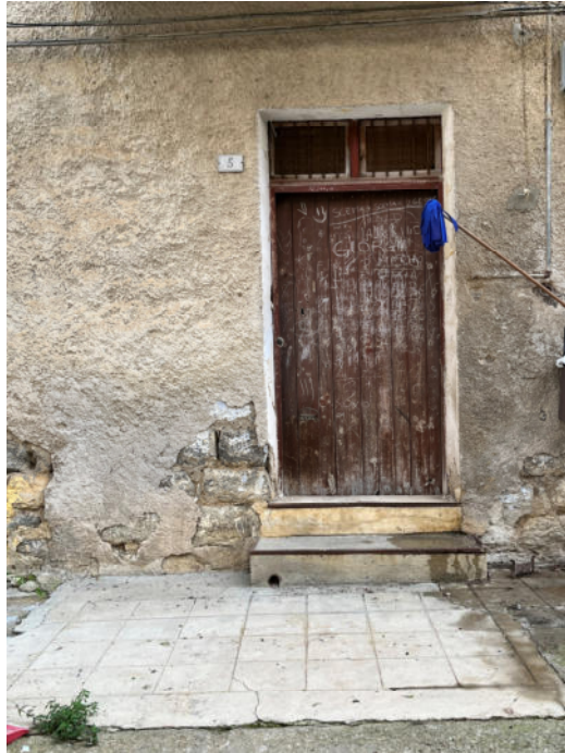
Foto 2 porta d'ingresso via Giardina 5
