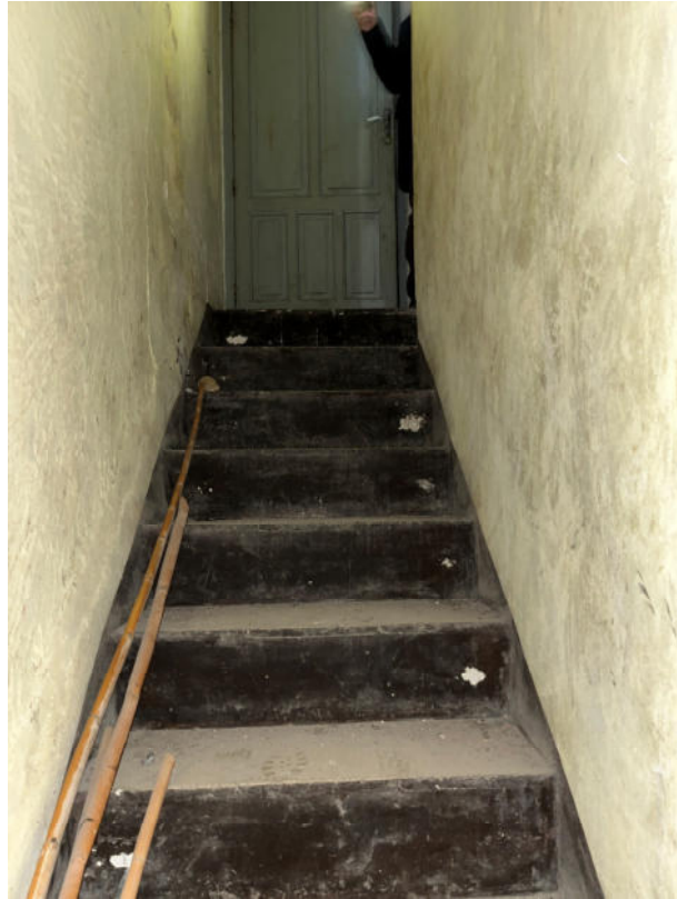
Foto 6 - scala di accesso al 1° piano
