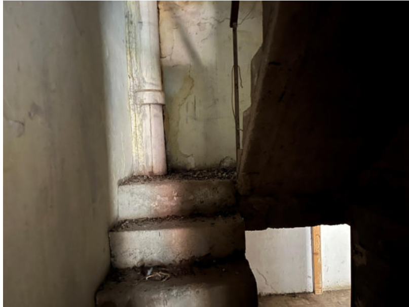
Foto 8 -2° piano - scala in c.c.a di accesso al 2° piano
