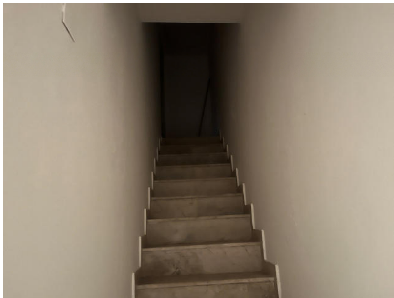
Foto 7 - 1° piano - scala di accesso al 2° piano
