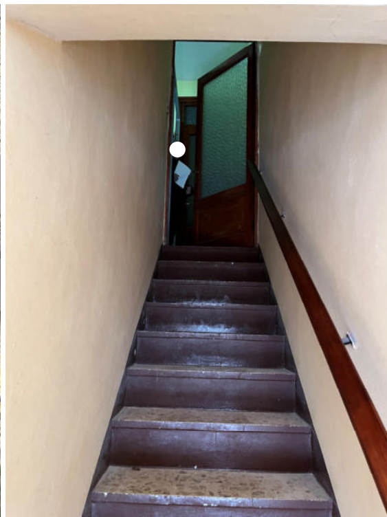
Foto 3 scala di accesso al 1° piano
