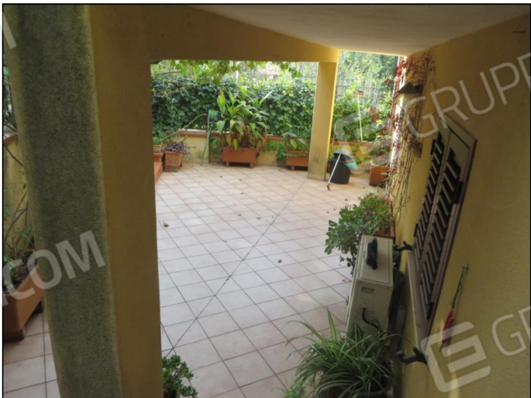
Portico ubicato in corrispondenza del prospetto principale (est)
