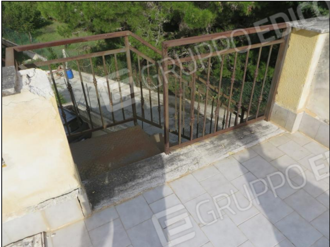
Particolare del muretto d'attico
