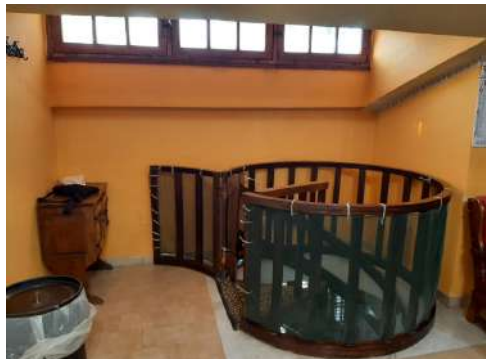
Scala a chiocciola di collegamento interno tra piano primo e piano secondo
