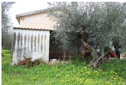
Tettoia in muratura e legno
