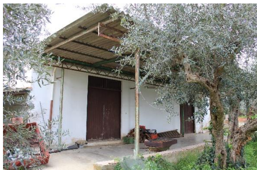
Tettoia metallica e pannelli in eternit
